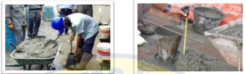
Gambar 4.10. Pengecekan uji slump beton
