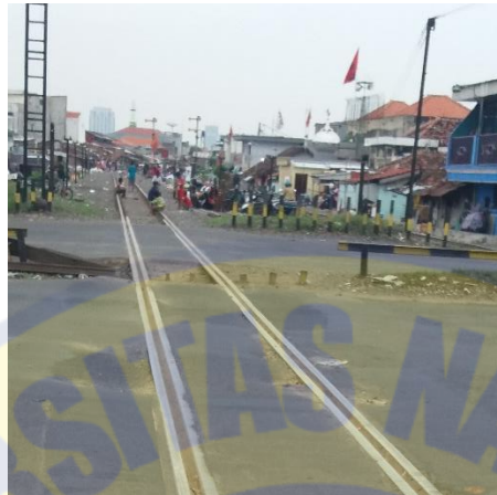
Gambar 4. 33 : Besi yang ditanam untuk menghalau pengendara putar balik di atas rel
