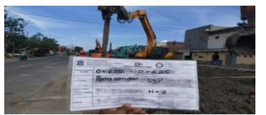
Pemasangan SteelSheet Pile
