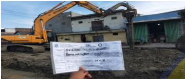
Pemasangan SteelSheet Pile
