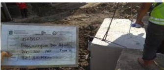
Pemasangan Box Culvert Top-Bottom Uk. 200.200.120 fc 35 Pabrikasi
