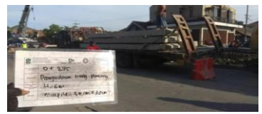
Pengadaan Tiang Pancang Mini Pile 30x30 cm H. 6 m fc 45 Mpa Pabrikasi
