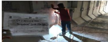
Pekeriaan Pengelasan Join Pelat Besi
