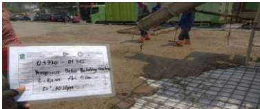
Pekerjaan Beton Bertulang fc 30 Mpa Tb. 15 cm (Untuk Overtopping Jalan) Dengan Besi Wiremesh M10-150
