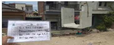
Pemasangan U-Ditch + Cover U-Ditch Uk. 100.145.120 fc 30 Moa Pabrikasi
