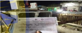
Pemasangan Top-Bottom 350.350.120 fc 35 Mpa Pabrikasi
