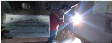
Pekeriaan Pengelasan Join Pelat Besi
