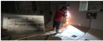
Pekeriaan Pengelasan Join Pelat Besi
