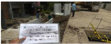
Pemasangan U-Ditch + Cover U-Ditch Uk. 100.145.120 fc 30 Moa Pabrikasi
