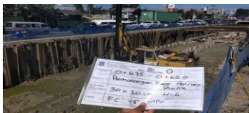
Pemasangan Tiang Pancang Mini Pile 30x30 cm fc 45 Mpa Pabrikasi
