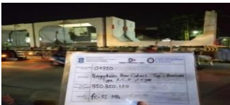
Pengadaan Box Culvert Top-Bottom Uk. 350.350.120 fc 35 Pabrikasi
