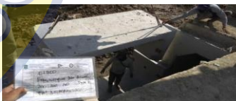
Pemasangan Box Culvert Top-Bottom Uk. 200.200.120 fc 35 Pabrikasi
