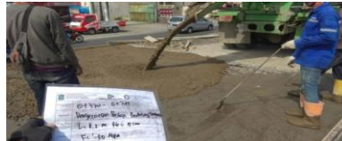
Pekerjaan Beton Bertulang fc 30 Mpa Tb. 15 cm (Untuk Overtopping Jalan) Dengan Besi Wiremesh M10-150
