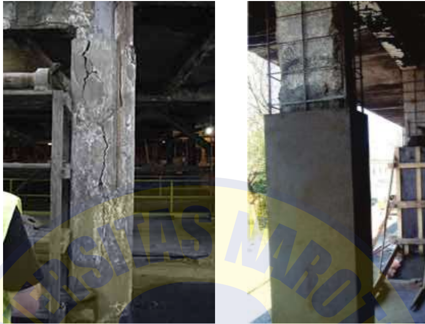
Gambar 2.1 Perkuatan Menggunakan Beton
