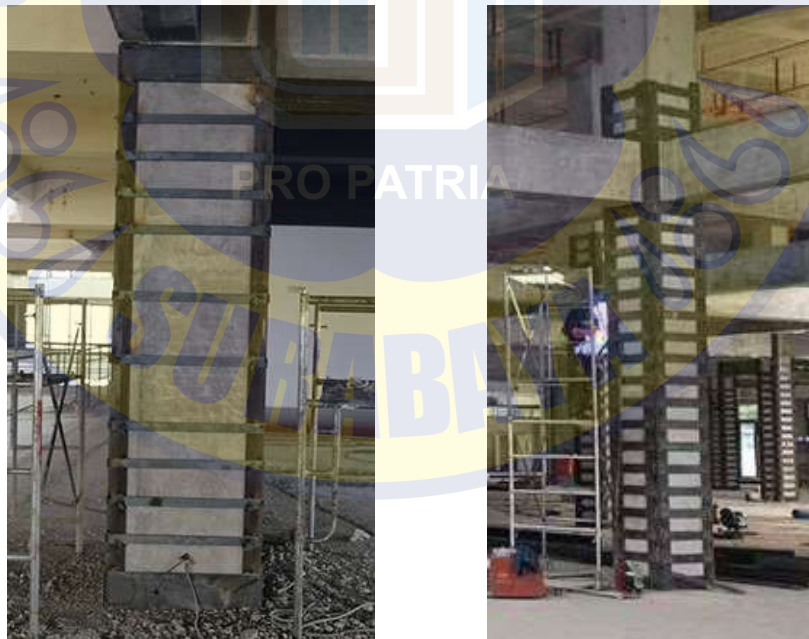
Gambar 2.2 Perkuatan Menggunakan Baja
