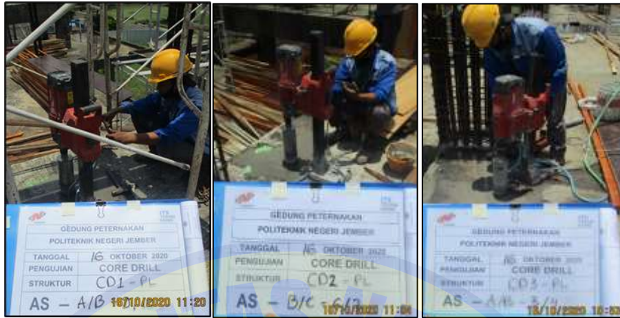
Gambar 4.56 Pelaksanaan Core Drill CD-1, CD-2, CD 3 (Pelat Lantai 2)
