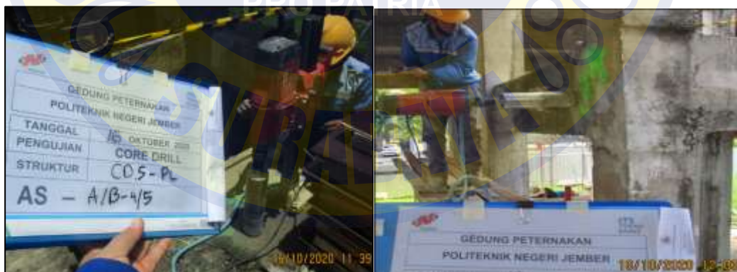
Gambar 4.58 Pelaksanaan Core Drill CD-5 dan CD-7 (Pelat dan Balok Area Bordes Tangga)
