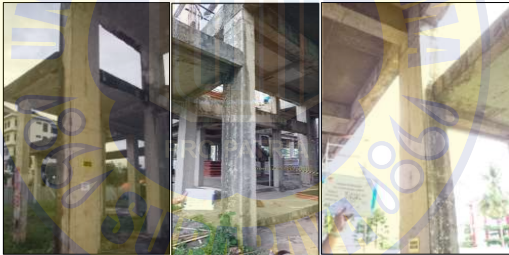
Gambar 4.5 Kolom As A-3 (K2) dengan Klasifikasi Kondisi Baik
