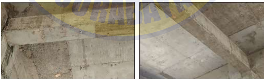
Gambar 4.8 Balok As D – E / 10 dengan Klasifikasi Kondisi Baik
