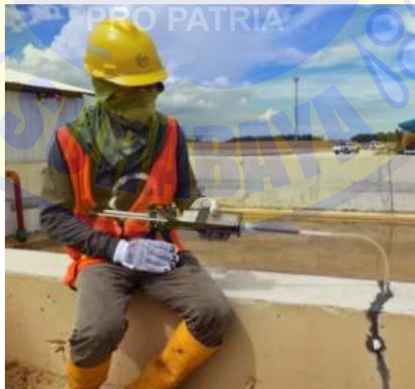
Gambar 4.73 Skema Pengerjaan Injeksi epoxy grout
