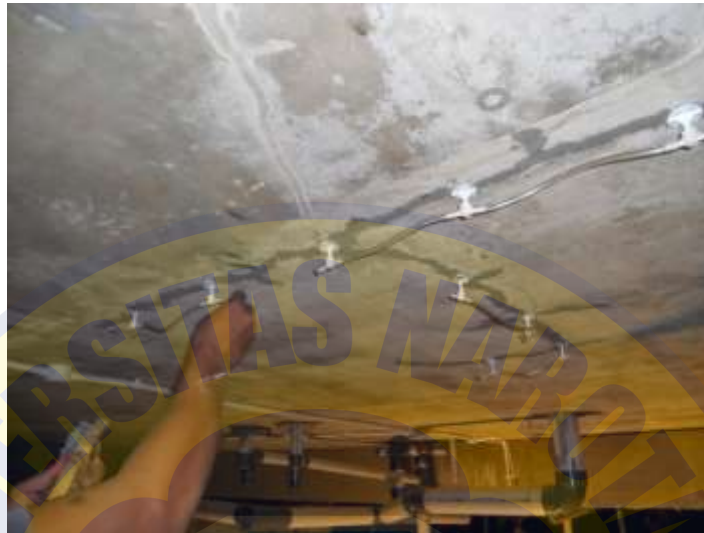
Gambar 4.72 Skema Pemasangan Nipple dan Penutupan Permukaan Retak
