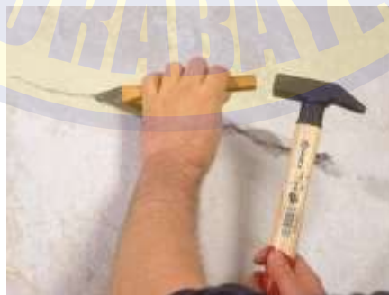
Gambar 4.71 Skema Pengerjaan Chipping Beton
