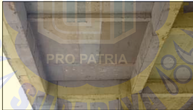
Gambar 4.11 Pelat As F – G / 9 – 10 dengan Klasifikasi Kondisi Baik
