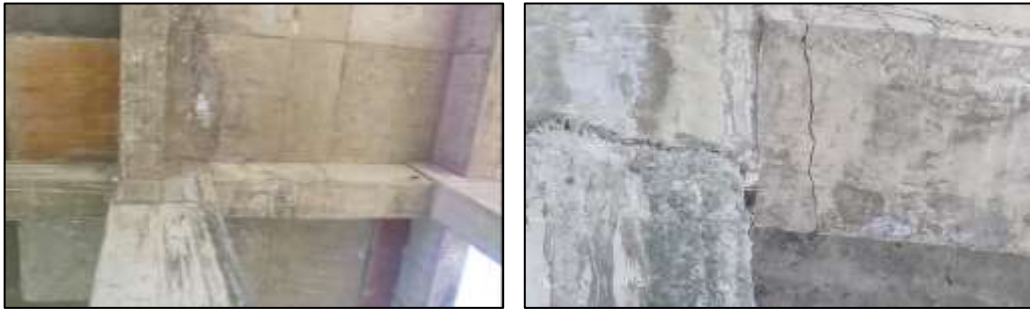
Gambar 4.9 Balok As B / 3 – 4 dengan Klasifikasi Kondisi Cukup Baik
