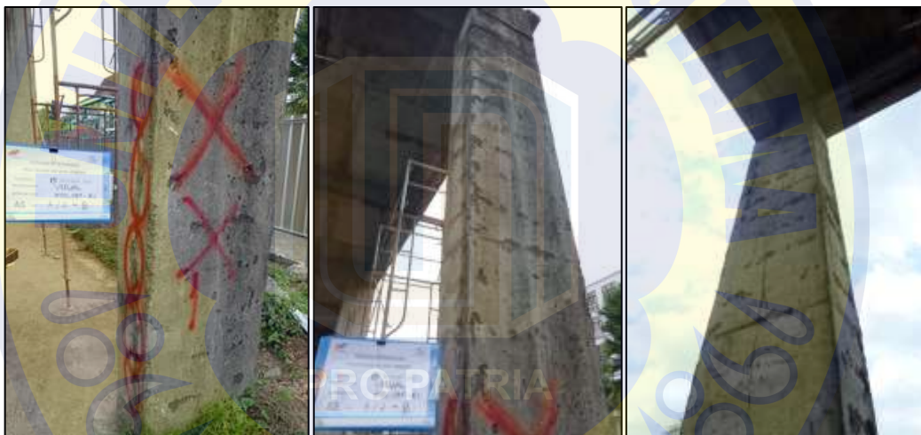
Gambar 4.7 Kolom As A-2 (K1) dengan Klasifikasi Kondisi Kurang sempurna
