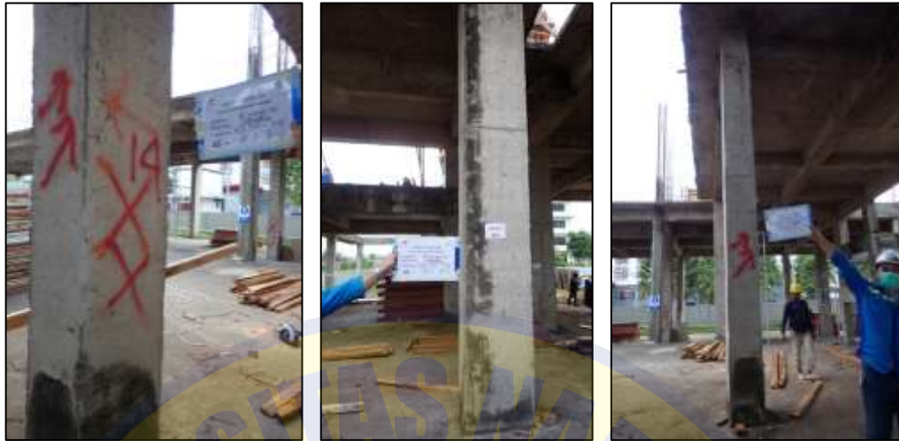
Gambar 4.6 Kolom As B' /8 (K3) dengan Klasifikasi Kondisi Cukup Baik
