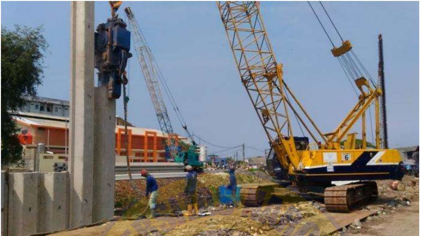
Lampiran 27. Gambaran Proses Pemasangan Sheet Pile Menggunakan Crane Hammer Diesel
