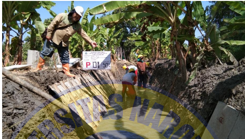
Gambar 4.3.2 Pekerjaan Galian Tanah ( Sumber : Dokumentasi Perusahaan )
